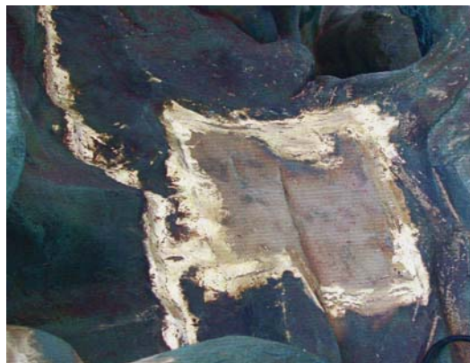
Abb. 22: Neugegossene, eingepasste Bronze- Flickstelle (aus BBL 2003)
