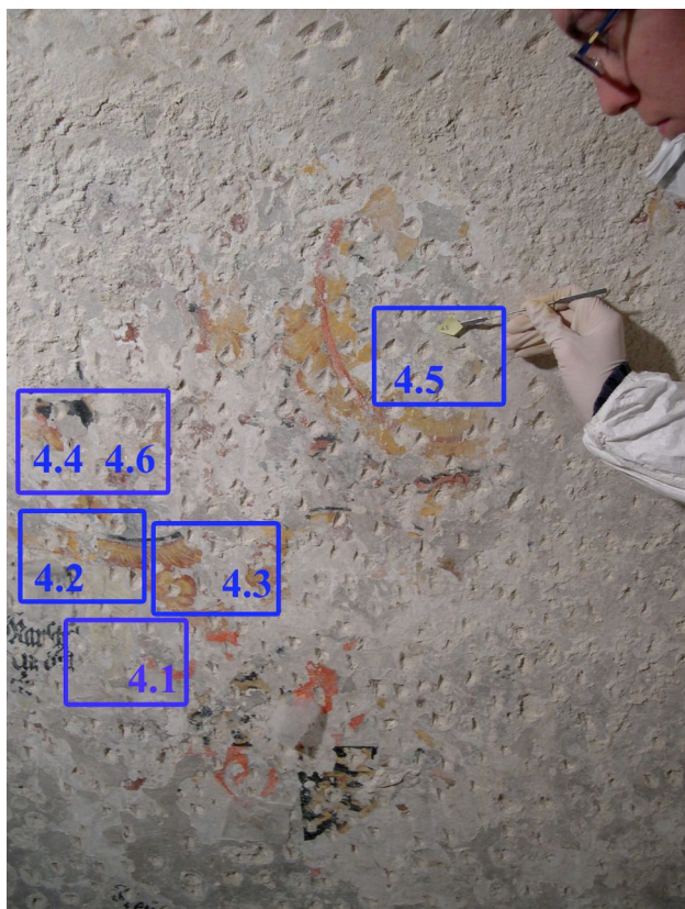
Ausschnitt Phase 4 (Gewölbe West) mit Proben 4.1 bis 4.6
