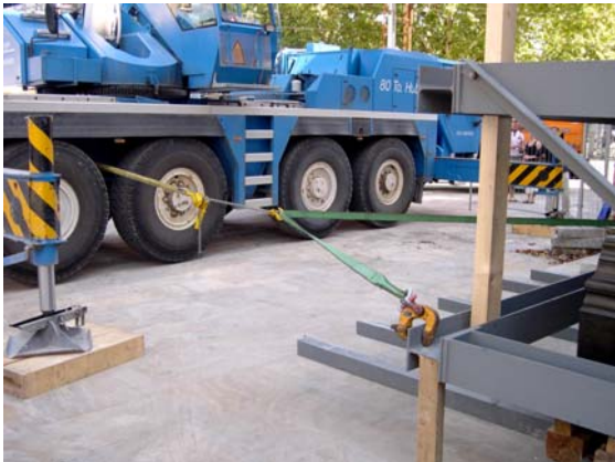
Abb. 94: Seitliche Sicherung am Kranwagen
