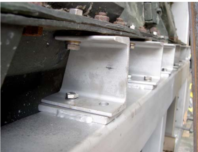
Abb. 79: U-förmige Stützen am mittleren Stützrahmen.
