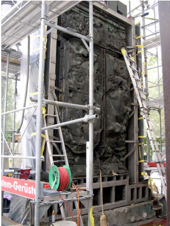
Abb. 84: Ausgetauschter Joch- und Stützrahmen.
