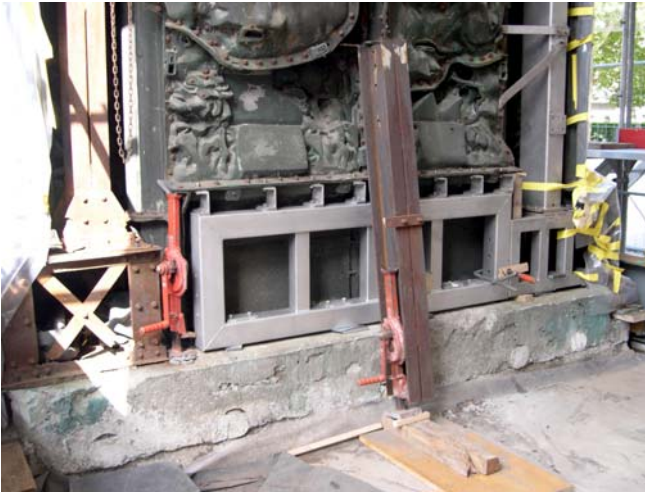
Abb. 78: Austausch des mittleren Stützrahmens
