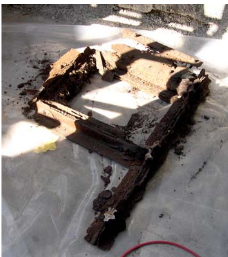
Abb. 74: Korrodierter alter Korpus teil
