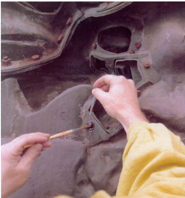
Abb. 113: Anstrich mit dem Penetriermittel „Owatrol-Öl“
