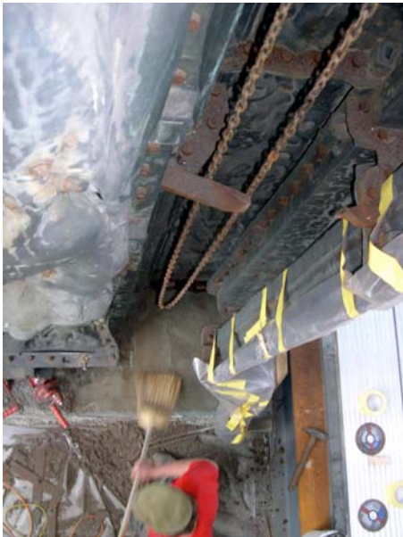
Abb. 73: Demontierte rechte Stützkonstruktion
