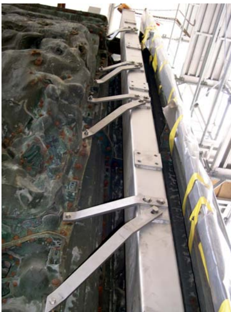
Abb. 77: Jochrahmen im rechten Pilaster
