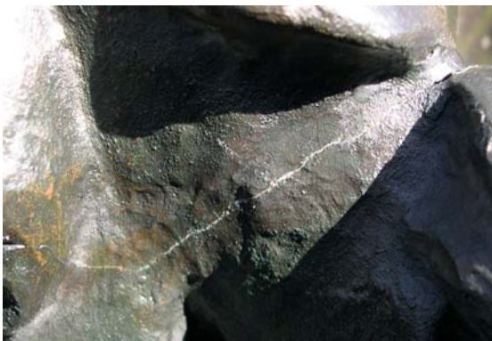
Abb. 98: Fuge, zwischen zwei Bronzeelementen
