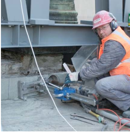
Abb. 51: Kernbohrungen im Sockel
