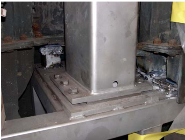
Abb. 76: Verschweissung der Platten.
