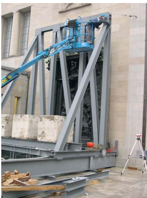
Abb. 50: Der Schlitten nach der Montage
