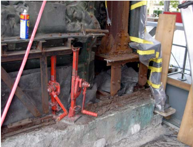
Abb. 72: Durchtrennter Stützrahmen
