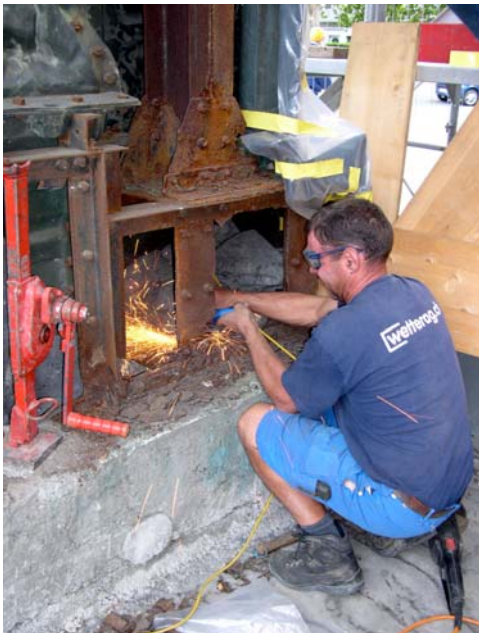
Abb. 71: Demontage des alten Korpus
