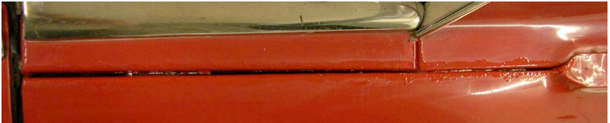
Abb.288: Linke Fuge nach dem Auftrag des Decklacks
