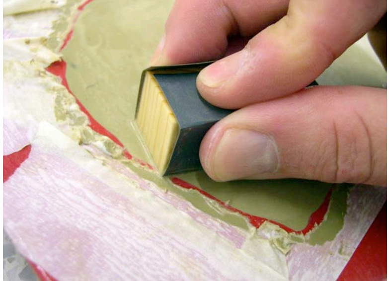
Abb.200: Schliff des Nitrokombispachtels
